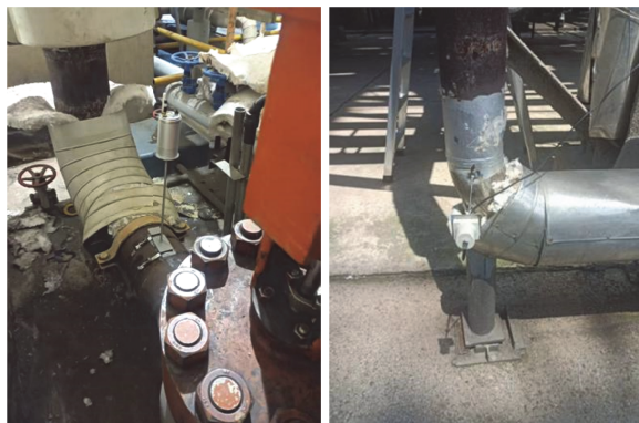
Рис. 7. Схема установки системы для контроля утечек
