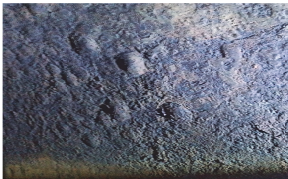
Рис. 7. Расслоение основного металла (блистеринг) корпуса нефтегазового сепаратора
